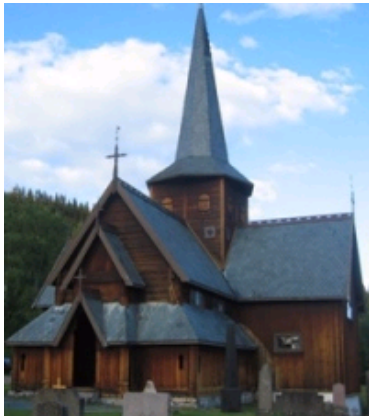
Bilde: Hedalen stavkirke
